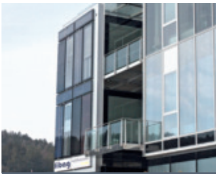
Total vermessen: 250 Messstellen mit 160 Sensoren liefern Daten der Fassade
